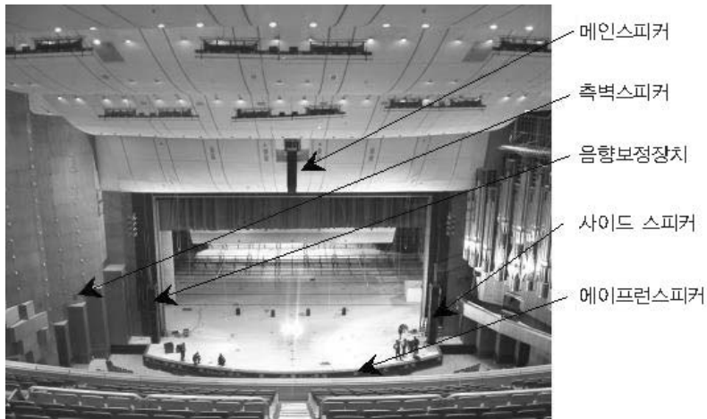
【그림 24】 객석 스피커 설치 사례
